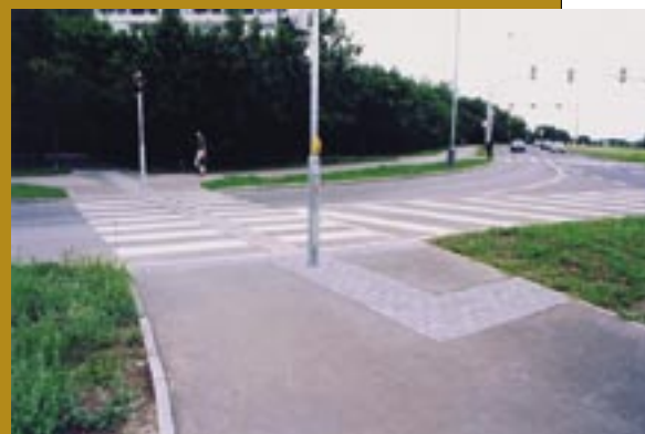
obr. 2 Hmatově a akusticky označený přechod (na sloupu semaforu je umístěn majáček)
